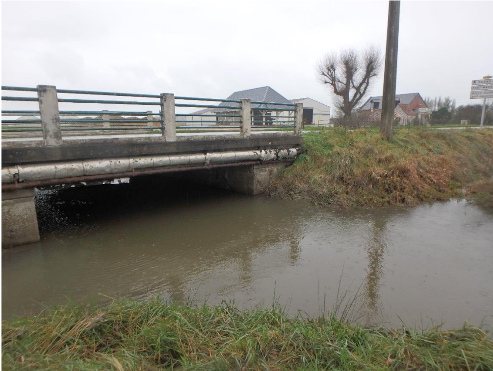
Figure 7 : Site amont de du canal de Retz à Quend (Monchaux)
