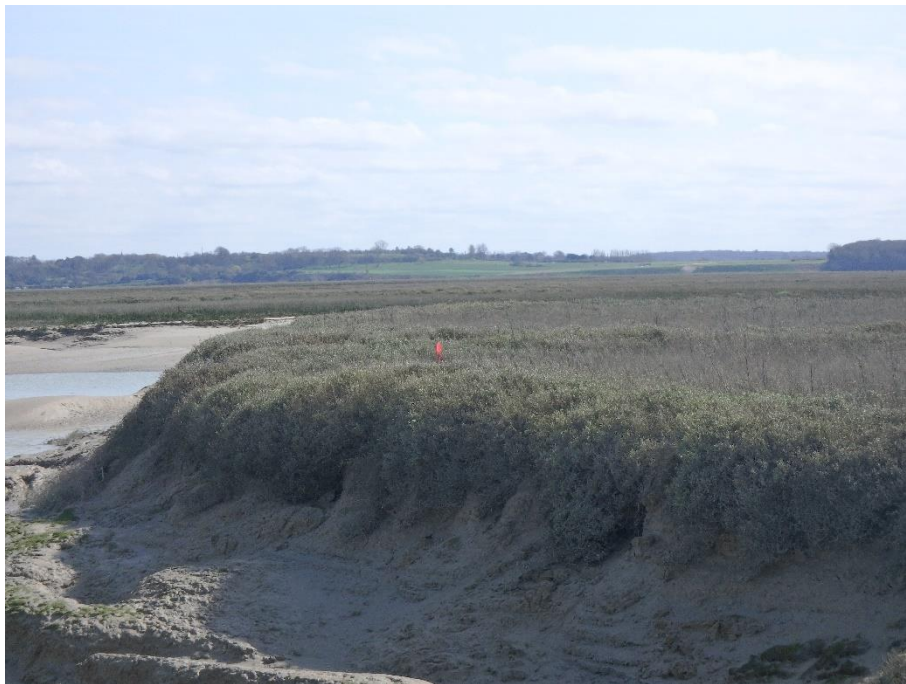
Figure 30 : Aperçu de la zone d'expérimentation non travaillée au Hourdel
